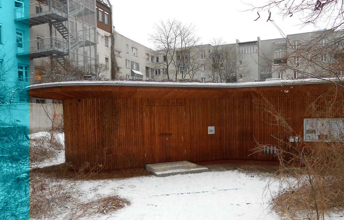
Abb.: Betriebsgebäude für Grauwasserbehandlungsanlage im Innenhof einer Wohnanlage in Berlin. Foto: ISOE 2014
