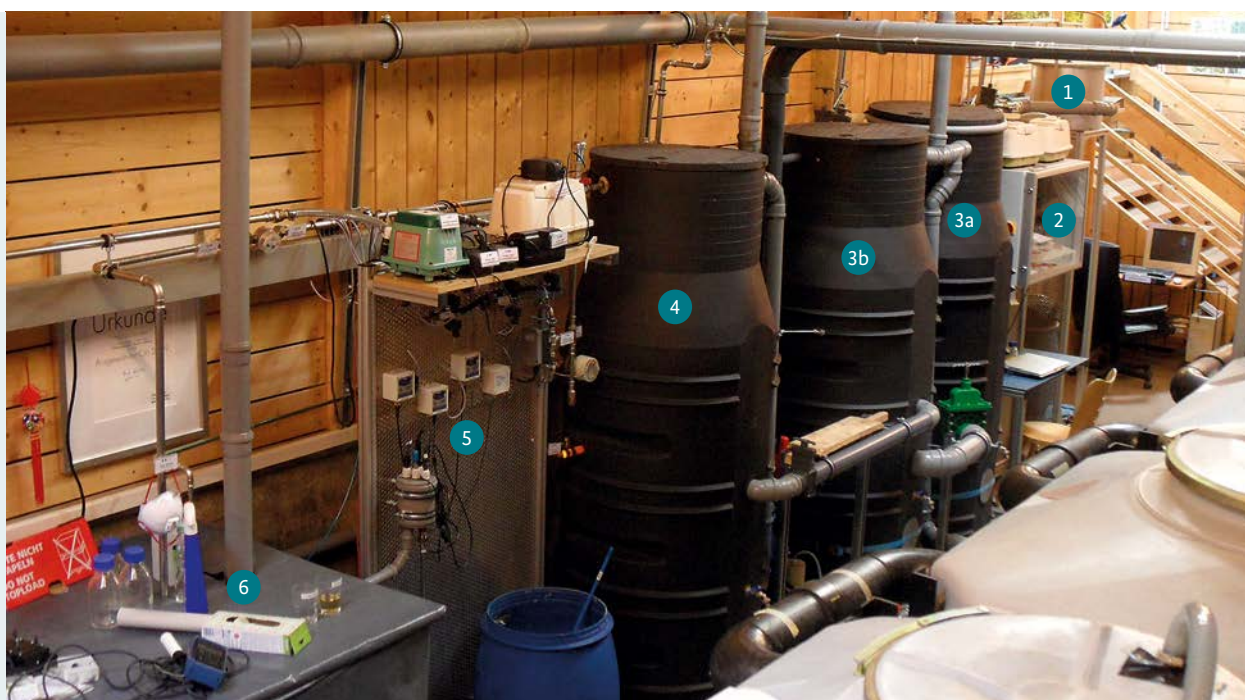
Abb. 1: Schwarzwasseraufbereitungsanlage
