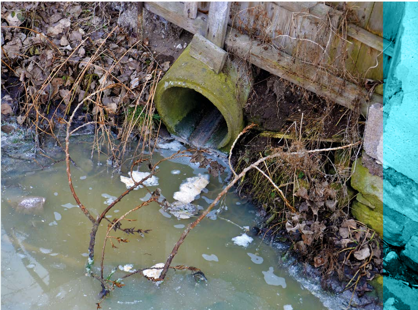
Abb. 2: Teilortskanal. Quelle: Jörg Londong
