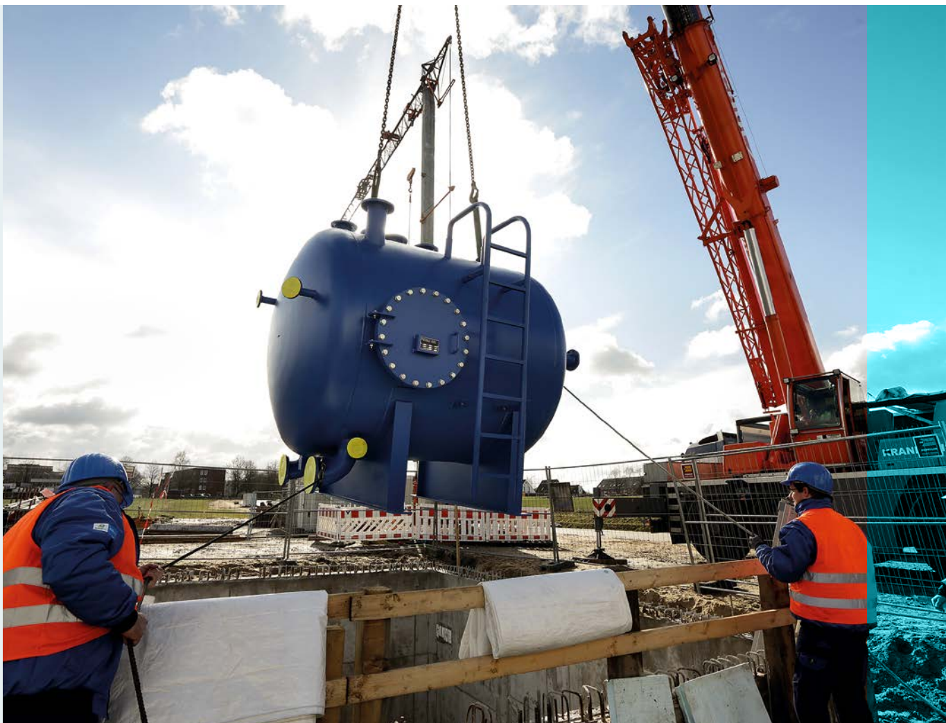
Abb. 3: Baustelle Jenfelder Au. Quelle: HAMBURG WASSER
