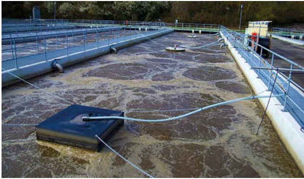
Abb. 4: Messungen in der Nitrifikationszone auf der Kläranlage Pforzheim. Quelle: Eigenbetrieb Stadtentwässerung Pforzheim (ESP) 2016
